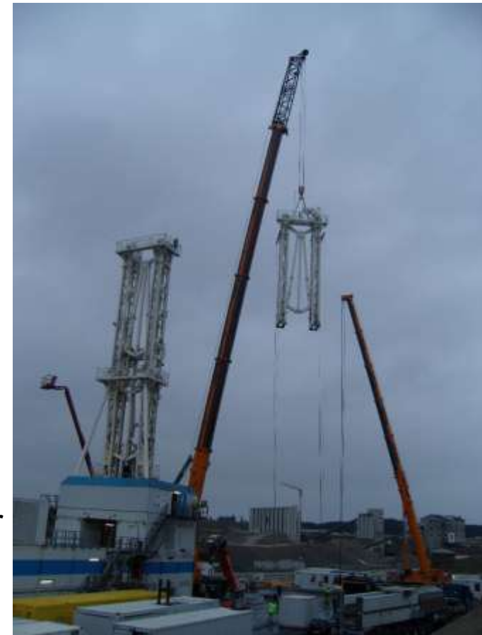
Aufbau der Bohranlage
