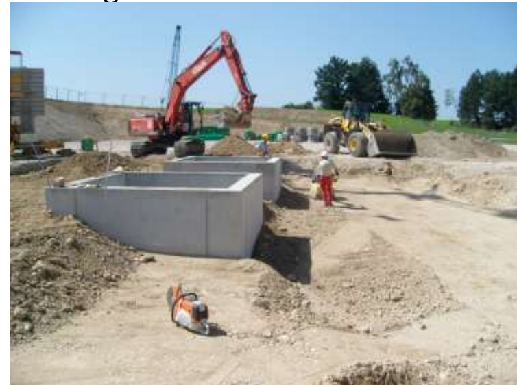
Bohrkeller als Startpunkte der Bohrungen
