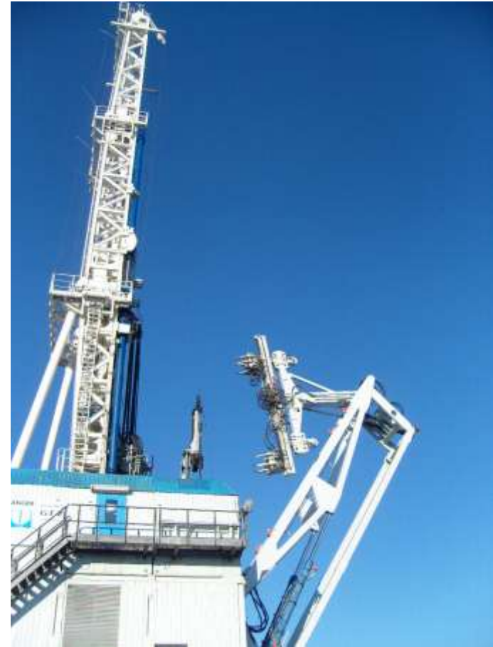
Bohranlage INNOVARig mit Pipe Handler
