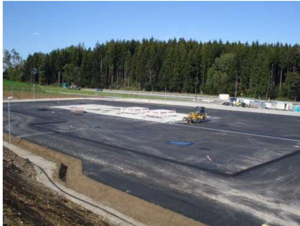
Vom Bergamt Südbayern abgenommener Bohrplatz Traunreut
