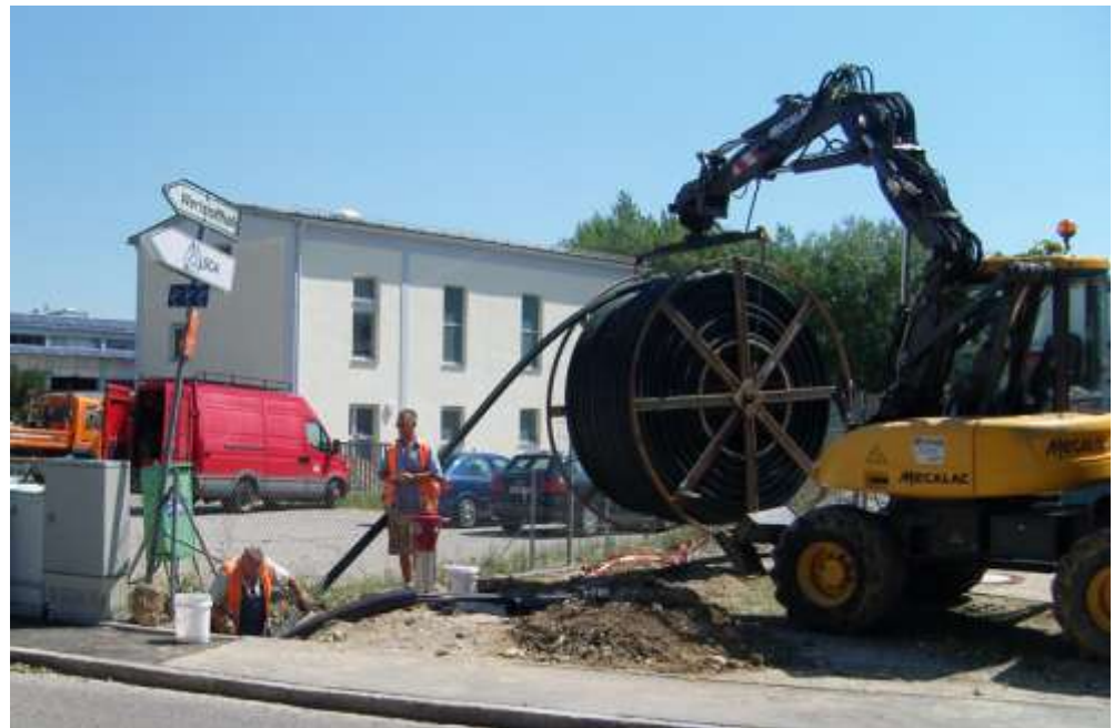
zeitweise Sperrung von Gehwegen und Straßen für Erdkabel- oder Leitungsbau in Traunreut
